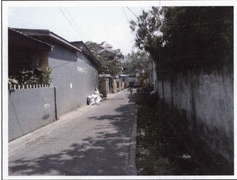
Gambar 8. Kondisi Saluran Drainase yang Tidak Terhubung dengan Sistem Drainase Perkotaan Sehingga Menimbulkan Genangan
