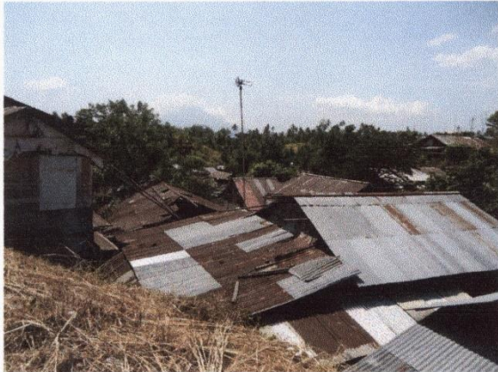
Perumahan/Permukiman Kumuh di Dataran Rendah
