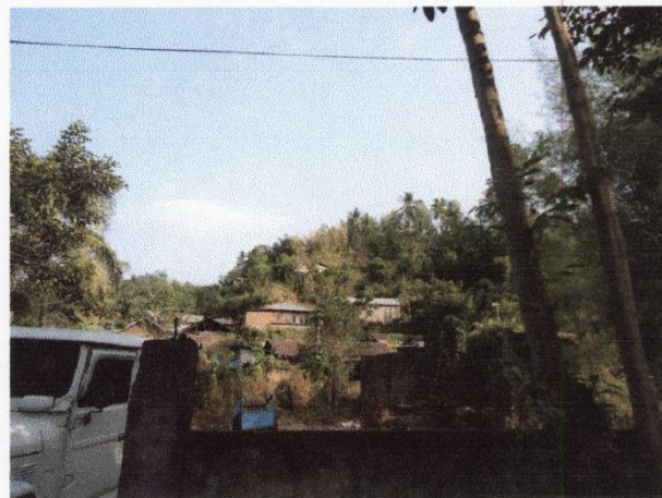
Perumahan/Permukiman Kumuh di Daerah Rawan Longsor
